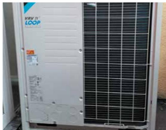
L'école de Houtain-Le-Val vient d'être équipée de pompes à chaleur air – air VRV de marque Daikin. Le passage à cette technologie permettra de réduire de 30 % les consommations énergétiques liées au chauffage de l'école. La com-
