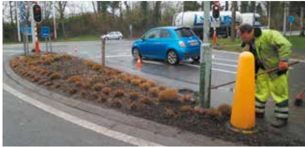
Travaux rue de Glabais
