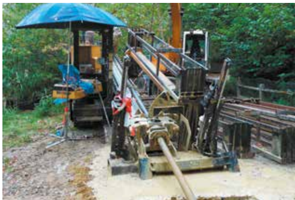
Travaux la motte
