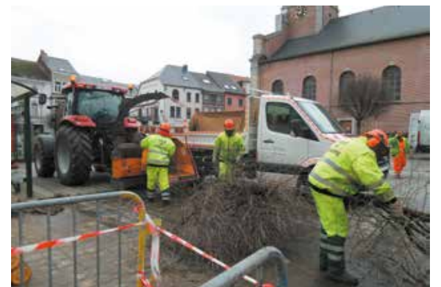
Travaux Place de Genappe
